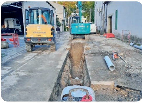
Travaux à Violès
