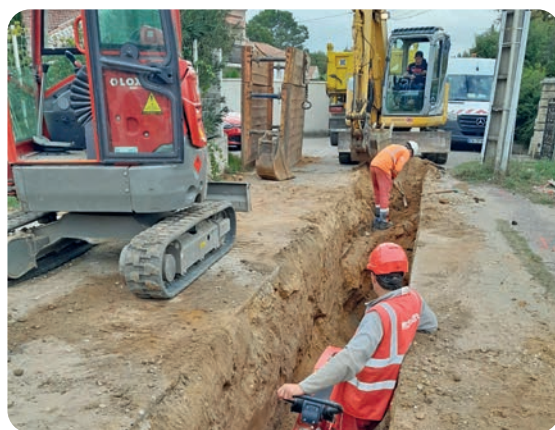
Travaux à Piolenc
